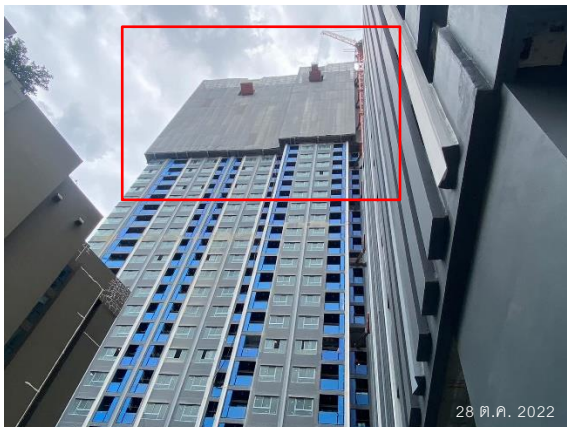
รูปที่ 2.63 Mesh Sheet คลุมรอบอาคาร
