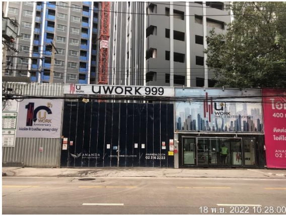
รูปที่ 2.1 รั้ว Metal Sheet ความสูง 6 เมตร
